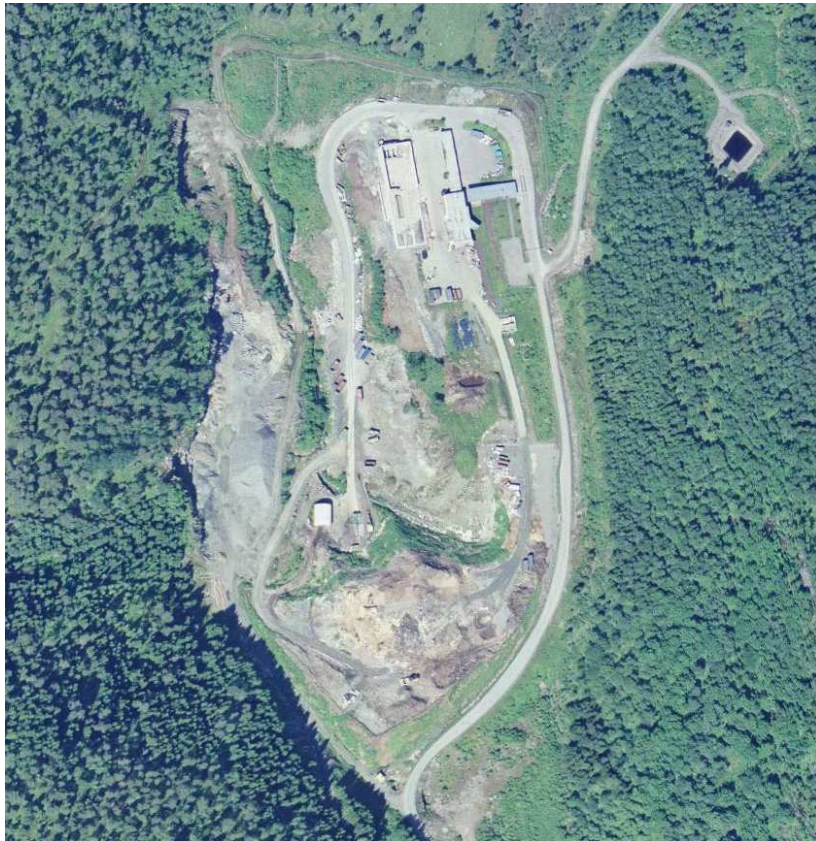
Figur 2. Flyfoto av Hesjedalen avfallsdeponi.
