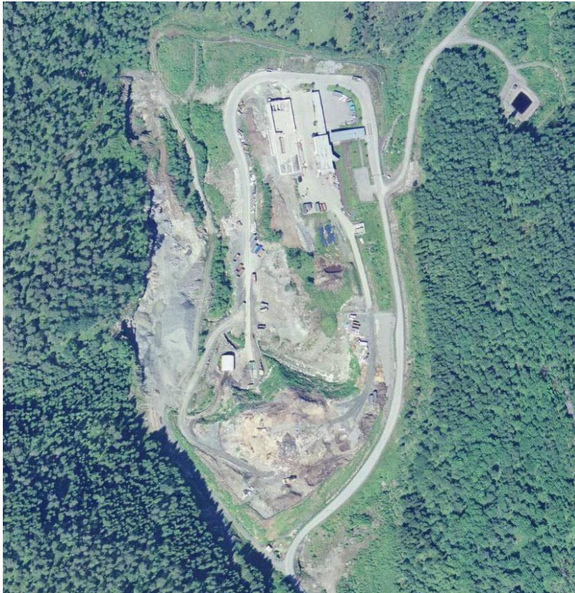
Figur 2. Flyfoto av Hesjedalen avfallsdeponi.
